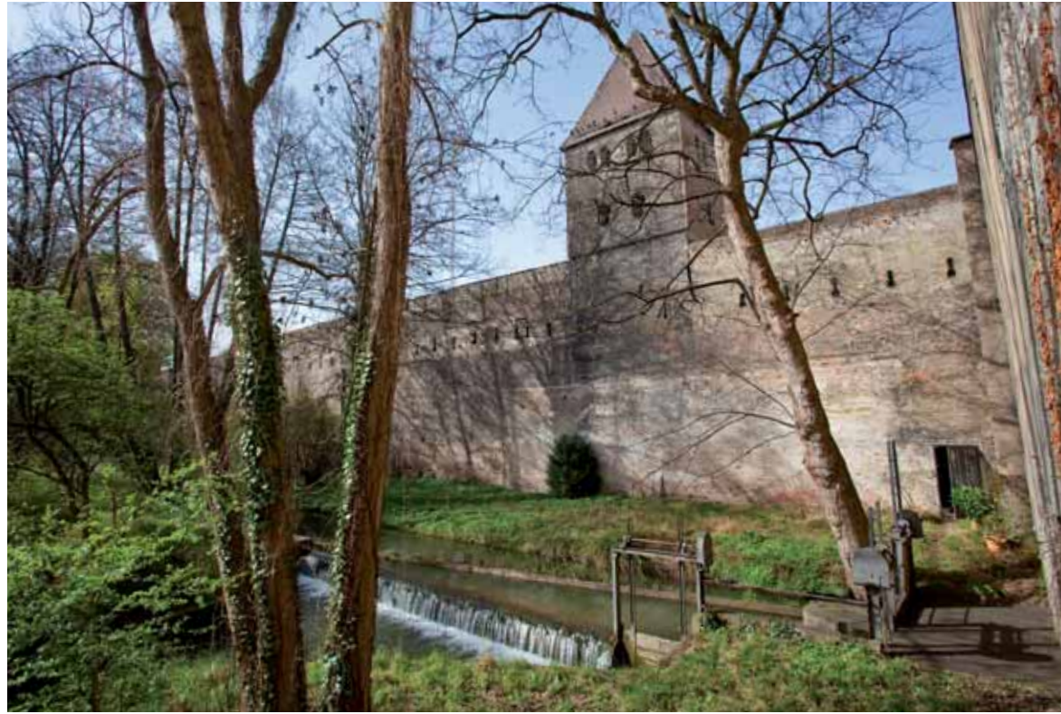
Dieser mittelalterliche Wehrturm in der Stadtmauer beim Vogeltor diente bis 1879 als Wasserturm. Die Funktion des Bauwerks geriet jedoch in Augsburg im Lauf der Jahre in Vergessenheit. Durch Recherchen zur historischen Augsburger Wasserwirtschaft konnte der jüngste und sechste erhaltene Wasserturm in der Stadt zweifelsfrei identifiziert werden.
