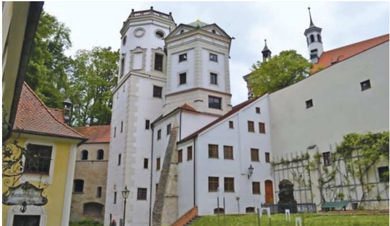
Ältestes in Mitteleuropa: Zwei der drei Türme des 1416 in Betrieb genommenen Wasserwerks am Roten Tor in Augsburg. Fotos: Traub
