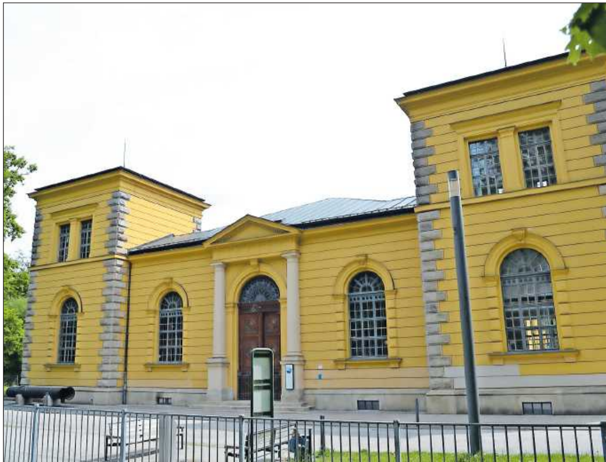
Das Augsburger Wasserwerk, auch architektonisch eine Besonderheit.
