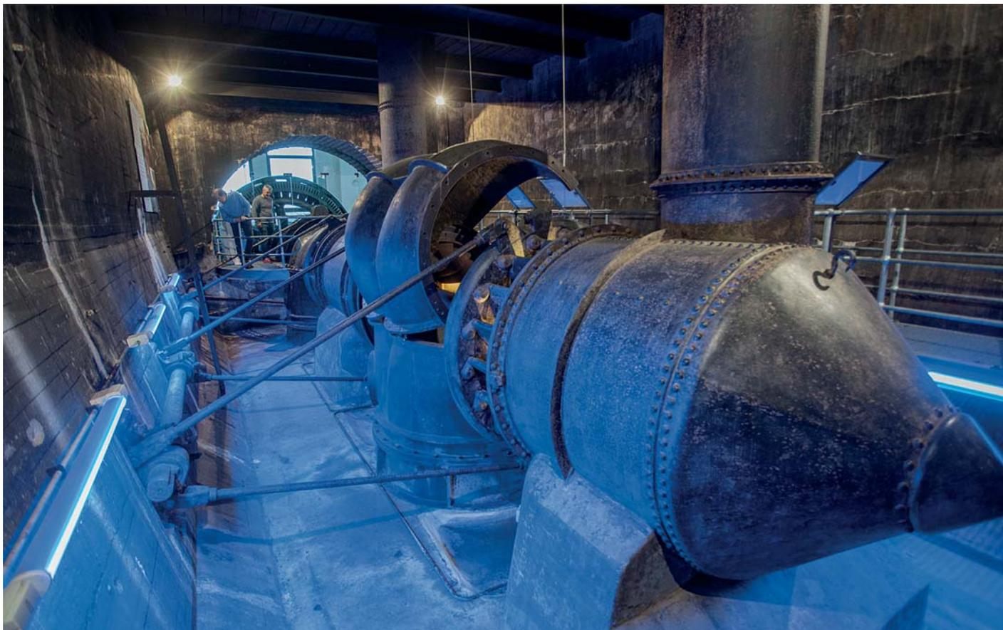
Im Lechmuseum Bayern in Langweid ist original erhaltene Kraftwerkstechnik aus der Zeit der Inbetriebnahme im Jahr 1907 zu sehen. Das Technikdenkmal einer jeweils begehbaren Turbinenkammer (oben) und Auslaufkammer (unten) ist einer der Gründe, wieso das bis heute Strom erzeugende Wasserkraftwerk der Lechwerke AG seit dem Jahr 2019 zu den 22 Objekten des UNESCO-Welterbes „Augsburger Wassermanagement-System“ zählt.
