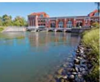
Im Lechmuseum Bayern in Langweid ist original erhaltene Kraftwerkstechnik von 1907 zu sehen. Das Strom erzeugende Wasserkraftwerk der Lechwerke AG in Langweid liegt am rund 18 Kilometer langen Nördlichen Lechkanal im Landkreis Augsburg. Seit 2019 gehört es zu den 22 Objekten des UNESCO-Welterbes „Augsburger Wassermanagement-System“.
