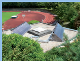
Solarkollektoren an der Freisportanlage Aichach erzeugen warmes Wasser für Sportler.
