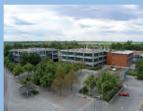
Das Schulzentrum des Schulverbands Mering nutzt Fernwärme aus dem mit Biogas betriebenen Blockheizkraftwerk.
