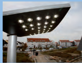
Energiesparende und zugleich umweltverträglichere LED-Leuchten wurden in einem Kissinger Baugebiet für die Straßenbeleuchtung installiert.
