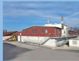
Die Biogasanlage der Familie Asum erzeugt Strom, die Abwärme trocknet Hackschnitzel.
