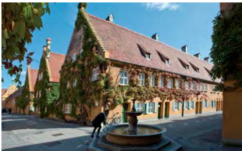
Kleine Häuser und eine große Stiftung: Jakob Fugger „der Reiche“ stiftete 1521 die älteste bis heute bestehende Sozialsiedlung der Welt.
