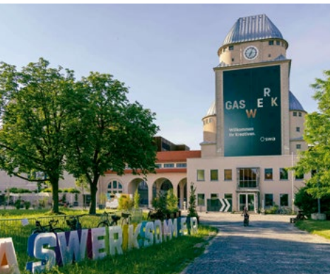
Das Gaswerk-Areal: pulsierendes Kultur- und Kreativzentrum mit Potential. Bild: Regio Augsburg Wirtschaft GmbH
