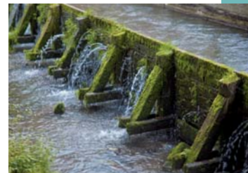
Wasserkraft – Treibwasserkanal vor der Getreidemühle.
