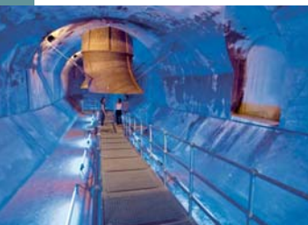
1907 entstand die begehbare Turbinenkammer des Wasserkraftwerks Langweid.
