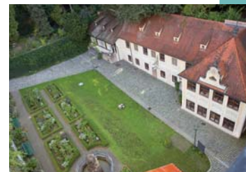
Der Blick vom Kleinen Wasserturm auf das Untere Brunnenmeisterhaus.
