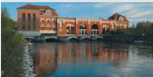
Das bis 1907 errichtete Wasserkraftwerk Langweid ist heute ein Bau- und Technikenkmal – und auch Bestandteil der weltbewürdigten historischen Augsburger Wasserwirtschaft.
