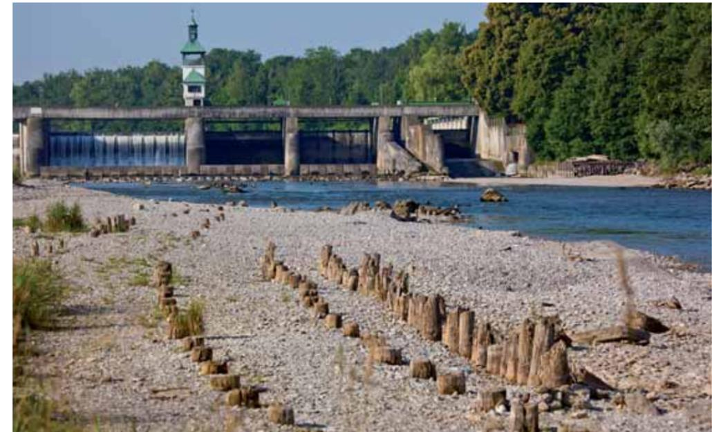
Der größte Teil des Lechwassers, der in den Lechkanälen durch das Lechviertel strömt, wird seit Jahrhunderten am Hochablass südöstlich der Altstadt ausgestaut. Das heutige Querbauwerk ist eine 1911/12 errichtete Stahlbetonkonstruktion. Ein noch aus Holz und Stein konstruiertes Wehr wurde 1910 durch ein Hochwasser völlig zerstört. Nur eine Reihe von Pfahlstümpfen ragt bei niedrigem Wasserstand aus der angrenzenden Kiesbank und erinnert noch an das frühere Stauwehr.
